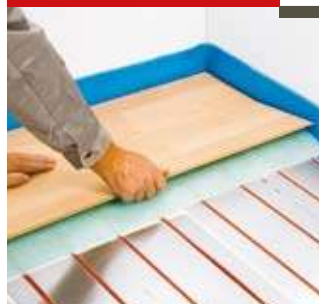
Укладка деревянного пола
