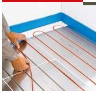
Укладка греющего кабеля
