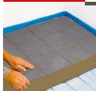
Укладка керамической плитки
