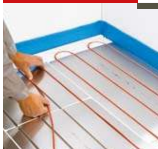
Укладка греющего кабеля
