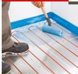
Нанесите грунтовку валиком
