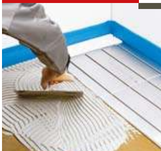
Укладка пластин
